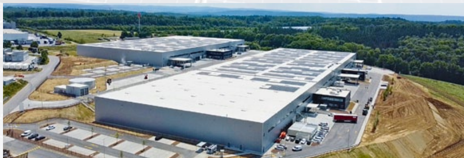
Der Mieter des Logistikzentrums in Möckmühl ist gegen Strompreisschwankungen abgesichert.
